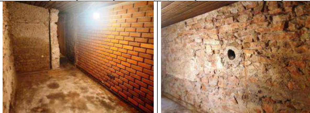
Skats uz vērtējamā objekta dzīvojamās ēkas (001) iekštelpām (001-4) pirmajā līmenī
