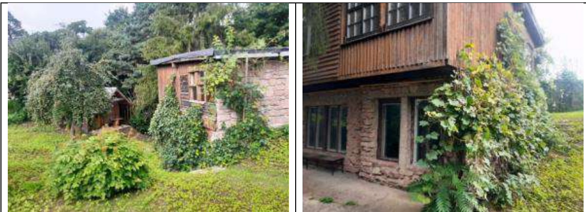
Skats uz vērtējamā objekta dzīvojamo ēku (001) pagalma (rietumu-ziemeļu) pusē
