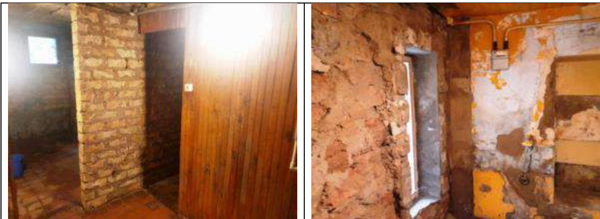
Skats uz vērtējamā objekta dzīvojamās ēkas (001) iekštelpām (001-4; 001-3) pirmajā līmenī
