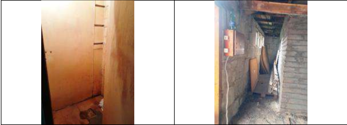
Skats uz vērtējamā objekta dzīvojamās ēkas (001) iekštelpu (001-9) un bloķētā garāžas (003) telpa (001-8) otrajā līmenī
